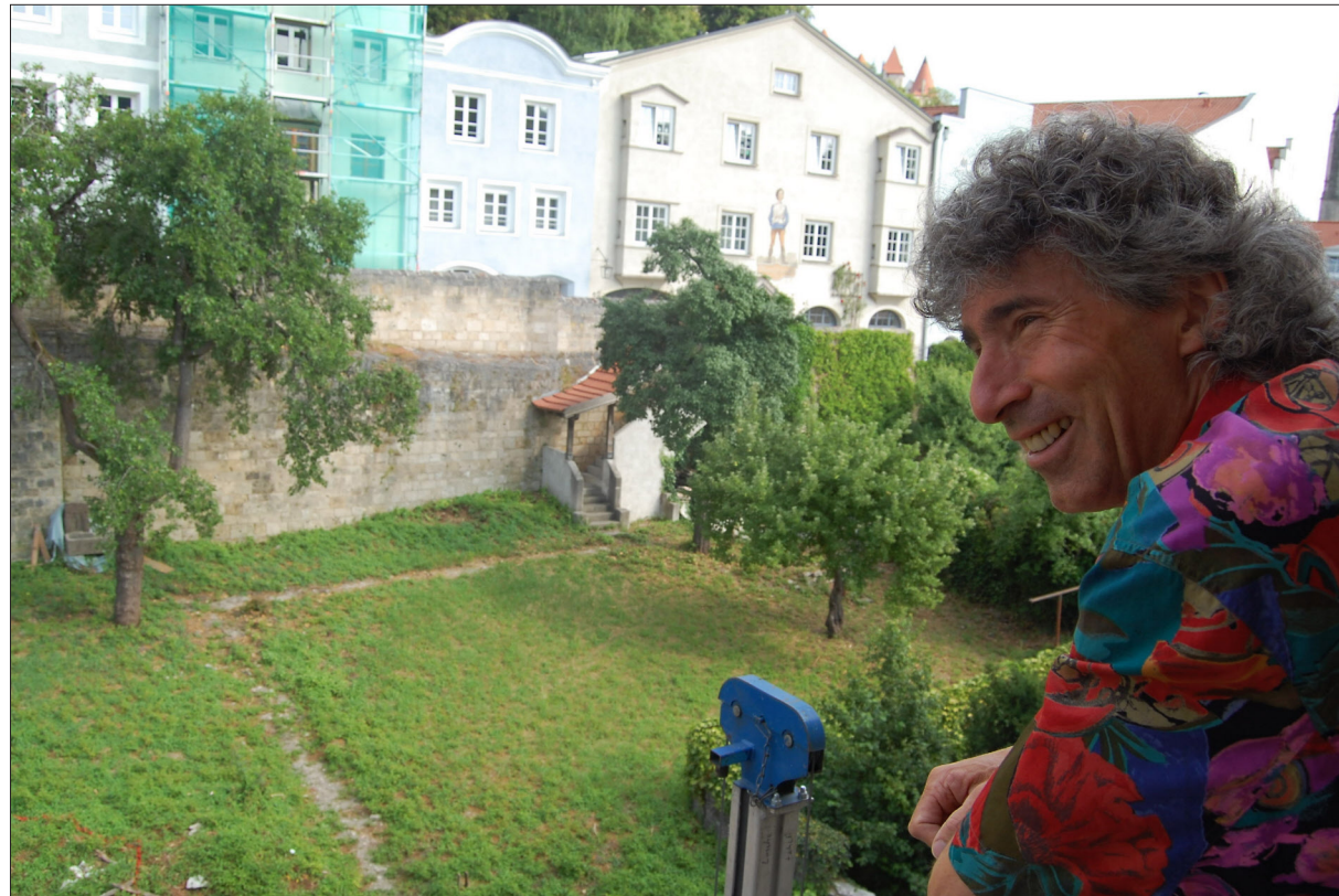
Die Wege durch die Wildnis sind im zweiten Stock vom Gerüst aus gut zu erkennen. Sie sind Reste der ursprünglichen Gartengestaltung des Baumeisterhauses. Und die will Roland Schumacher nachempfinden.
