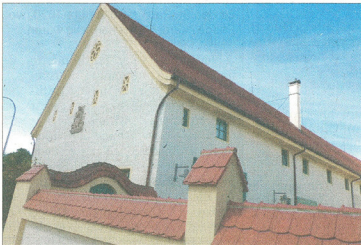
Ein echter Hinschauer – das renovierte Ökonomiegebäude.
