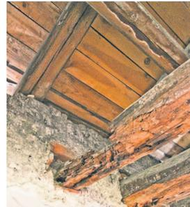
**Feuchtigkeit und die daraus resultierende Fäulnis haben der Dachkonstruktion stark zusetzt.** (Foto: Kaiser)
