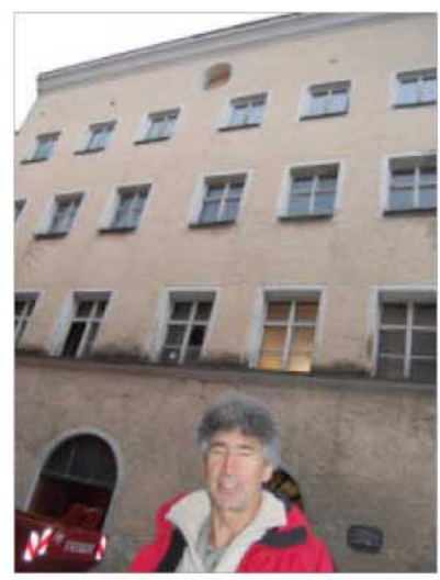
Die jetzige Fassade wird restauriert, Barock nicht nachgebaut.
