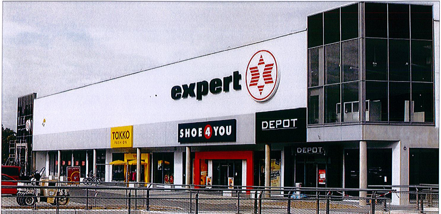
Das neue Fachmarktzentrum am Tor zur Innenstadt: Im Obergeschoss befindet sich expert; im Erdgeschoss finden sich Takko, Shoe4You, DEPOT und dm.
